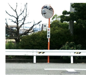
カーブミラー設置
