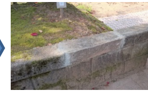
公園ブロック補修
