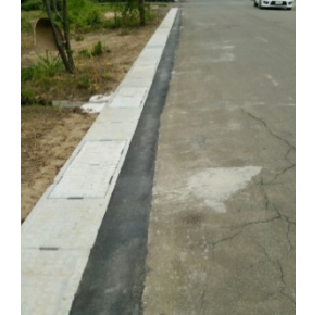
門型側溝整備
